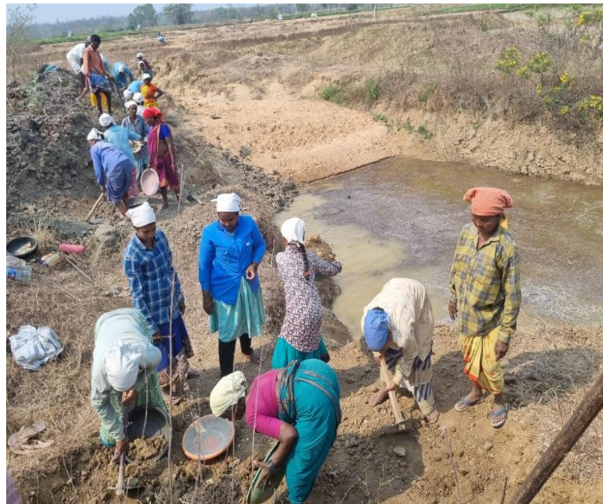
Photo: MGNREGA site.
