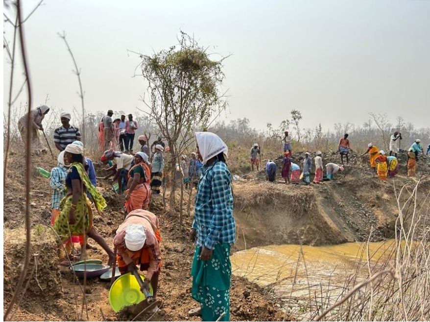
Photo: MGNREGA site.
