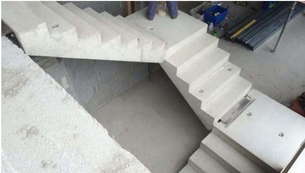
Fig: Precast staircase
