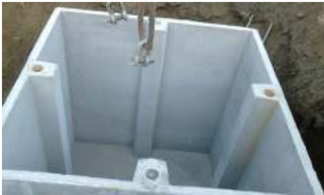
Fig: Precast UG Sumps
