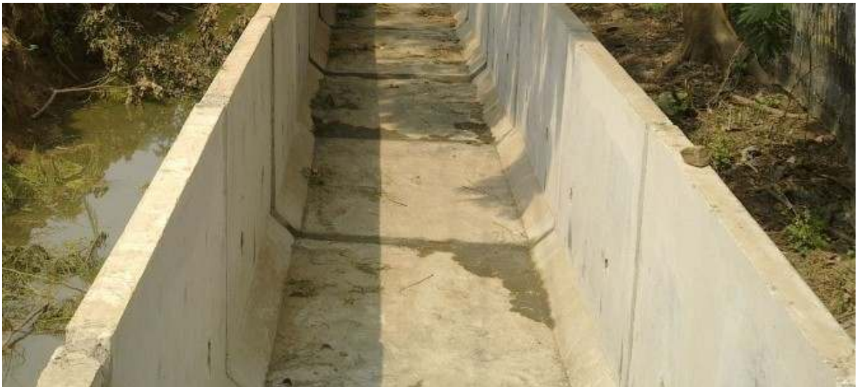
Fig: Precast Storm Water Drain
