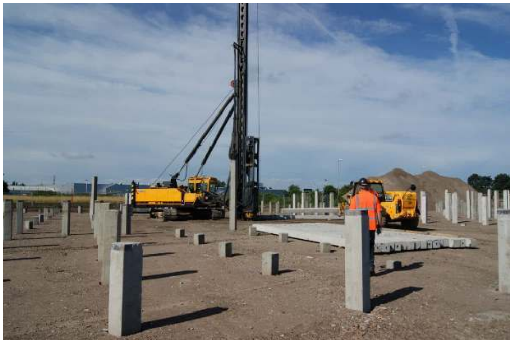
Fig: Precast piles
