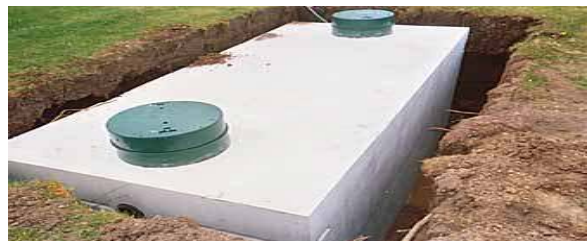
Fig: Precast UG Sumps
