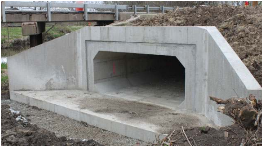
Fig: Precast box culverts
