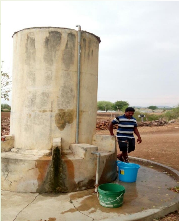
Mini Water Tank
